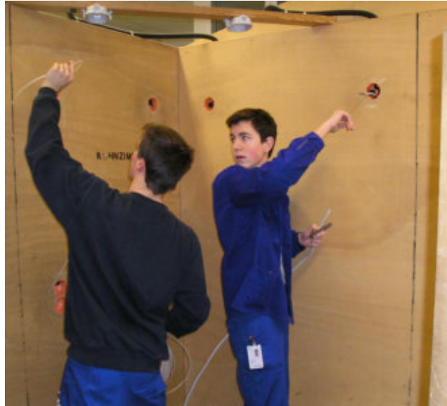
Azubis bei der Installation
